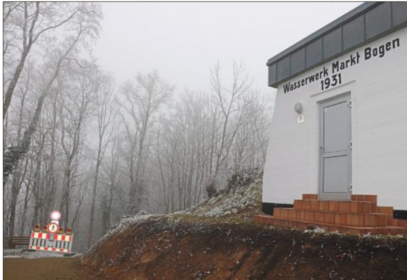
Sperrungen der Trinkwasserversorgung sind während der Bauphase nur in Einzelfällen notwendig.
